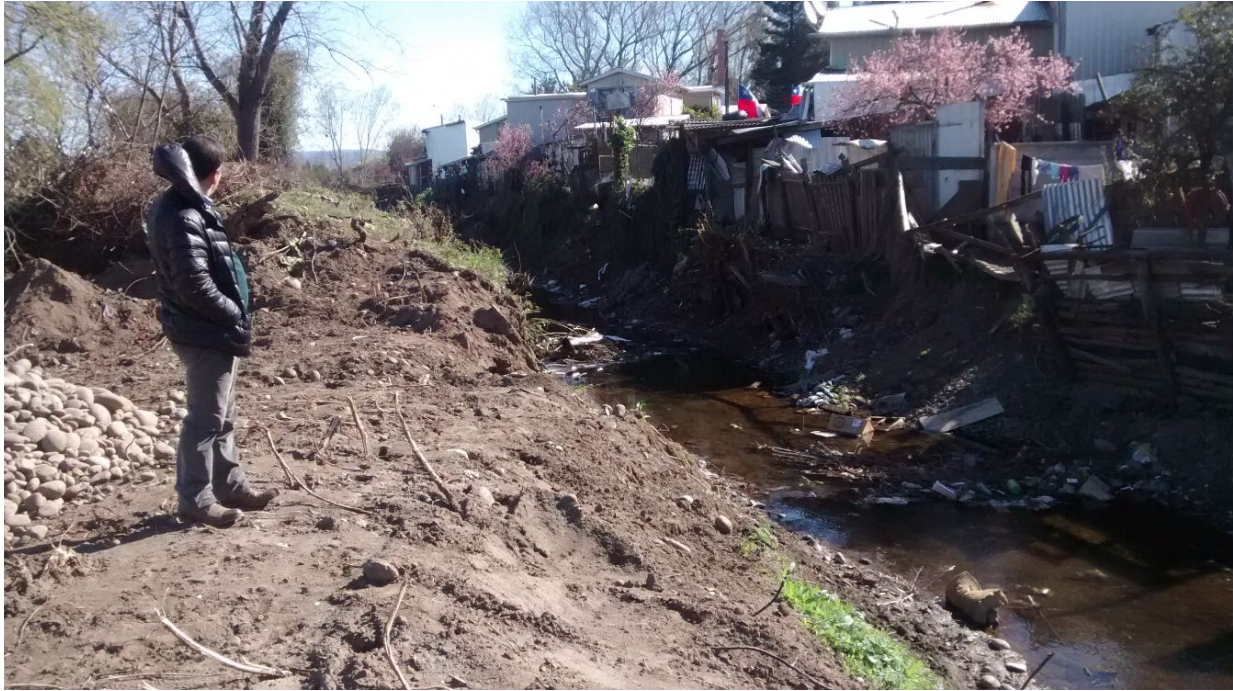
Imagen 5: Paso de canal de riego por el área urbana de Negrete.
