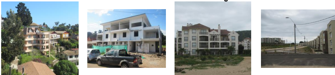
Ilustración 7.1-10 Caracterización de edificaciones Rango de Altura 3 a 5 Pisos
