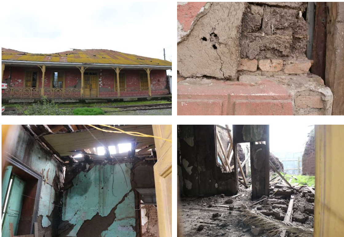
Figura 11: Estado actual de la Estación de Placilla.
