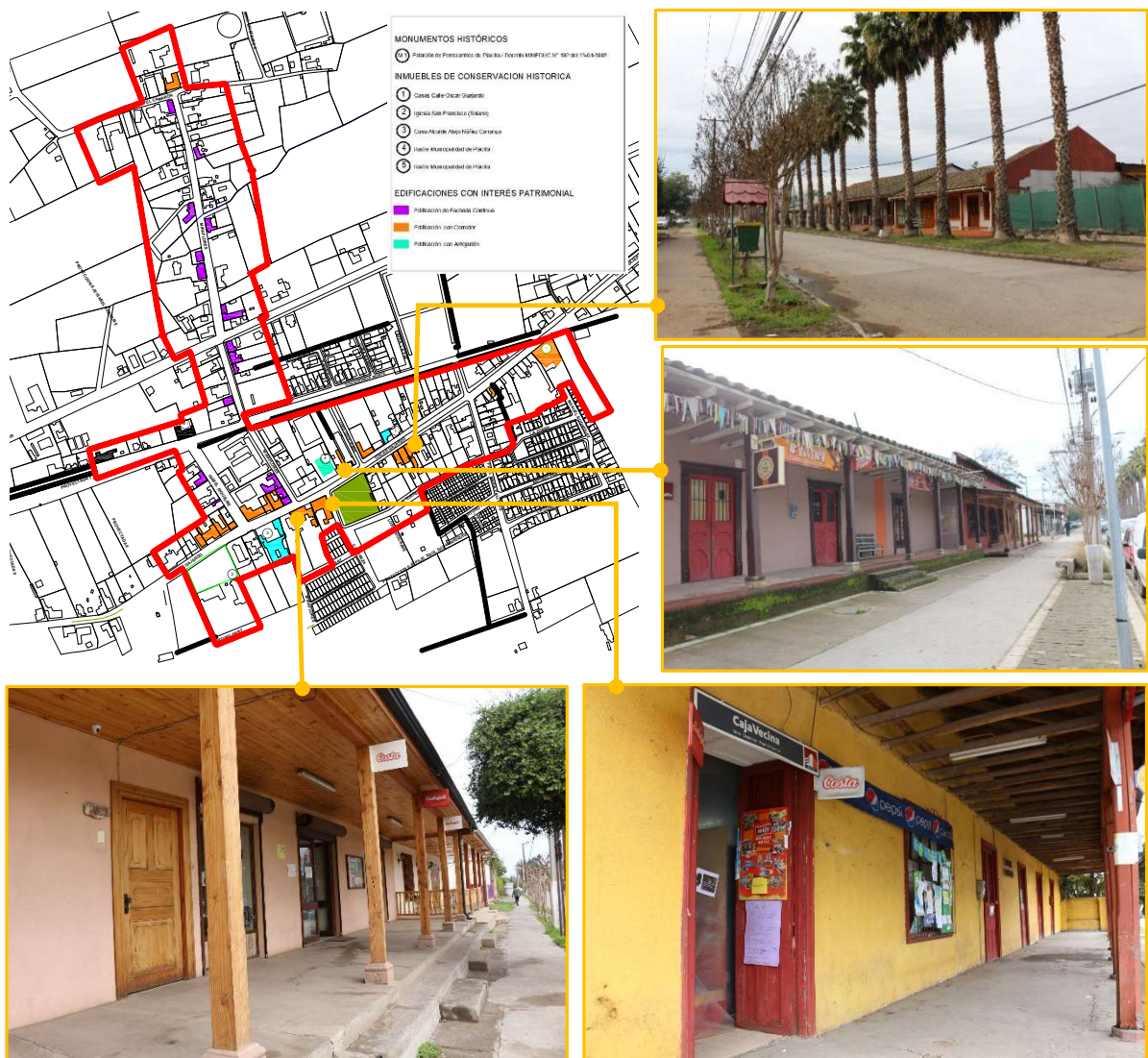
Figura 13: Edificaciones existentes en Calle Oscar Gajardo de Placilla.
