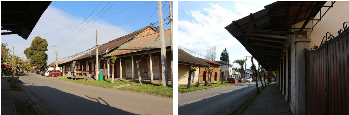
Figura 31: Imágenes de Edificaciones en Avenida Cardenal Caro.
