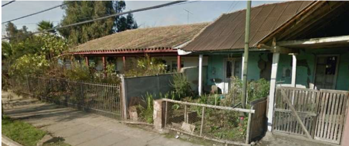
Figura 32: Imagen de Edificaciones en Avenida Cardenal Caro.
