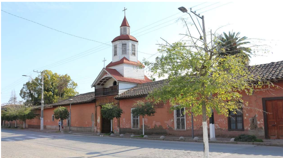
Figura 33: Imagen de fachada de edificio Casa de Ejercicio Cailloma.
