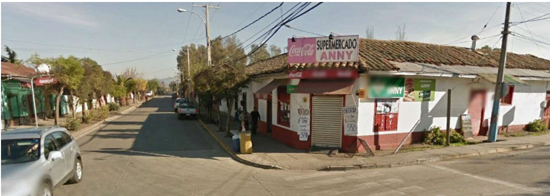
Figura 36: Imagen de Edificaciones Avenida Argomedo.
