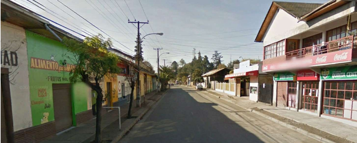
Figura 37: Imagen de Edificaciones de Avenida Argomedo
