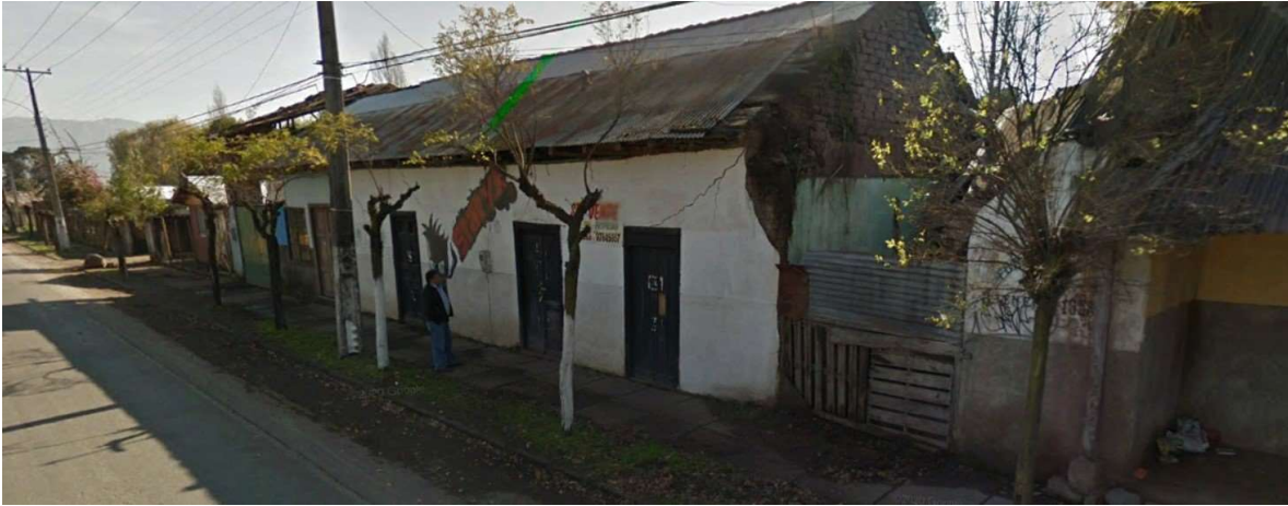
Figura 39: Imagen de Edificaciones acceso norte a localidad de Quinta de Tilcoco.
