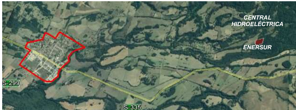
Figura 32. Ubicación Central Hidroeléctrica Enersur
