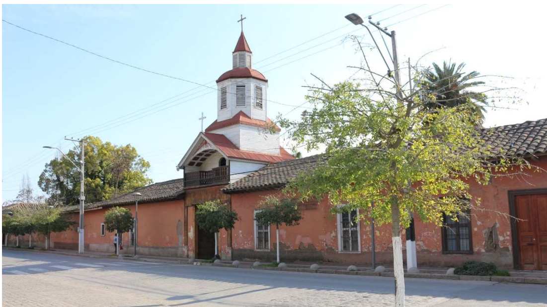
Figura 35: Imagen de fachada de edificio Casa de Ejercicio Cailloma.
