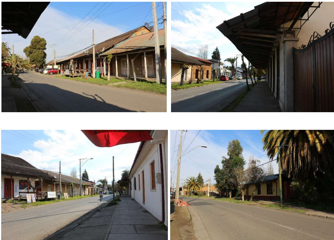
Figura 33: Imagenes de Edificaciones en Avenida Cardenal Caro.
