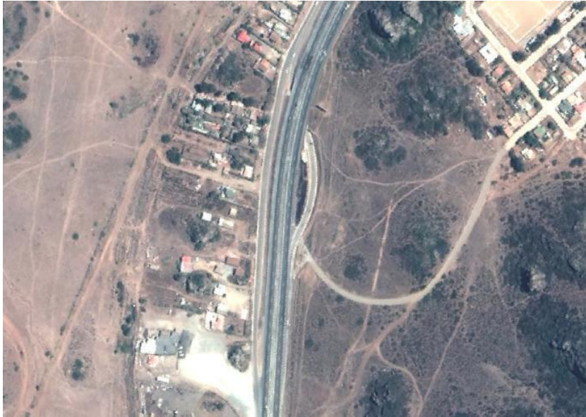
FIGURA N° 6-25: Cruce desnivelado Ruta 5; Pichidangui sur. Año 2017.
