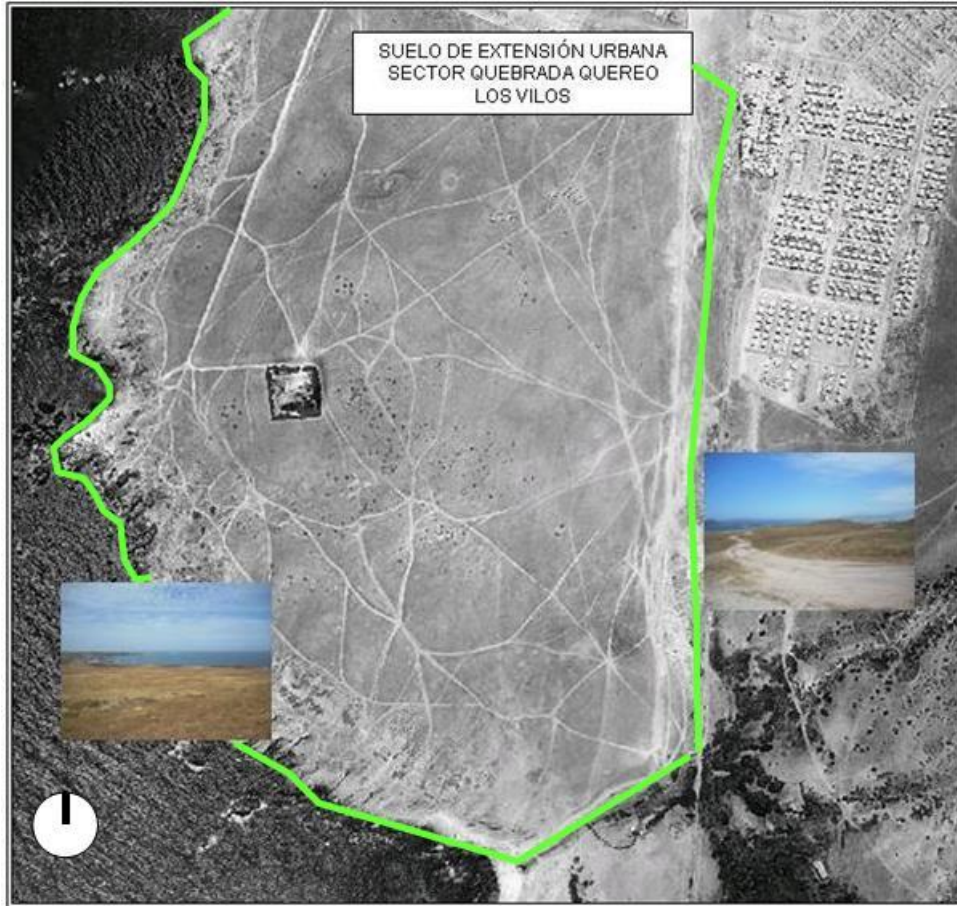
FIGURA N° 6-6: Suelo de Extensión Urbana, Sector Quebrada Quereo; Los Vilos. Año 2012.
