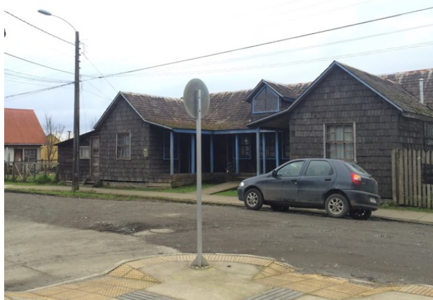
FIGURA N° 10-40 Fachada Oriente, Plaza de Puqueldón
