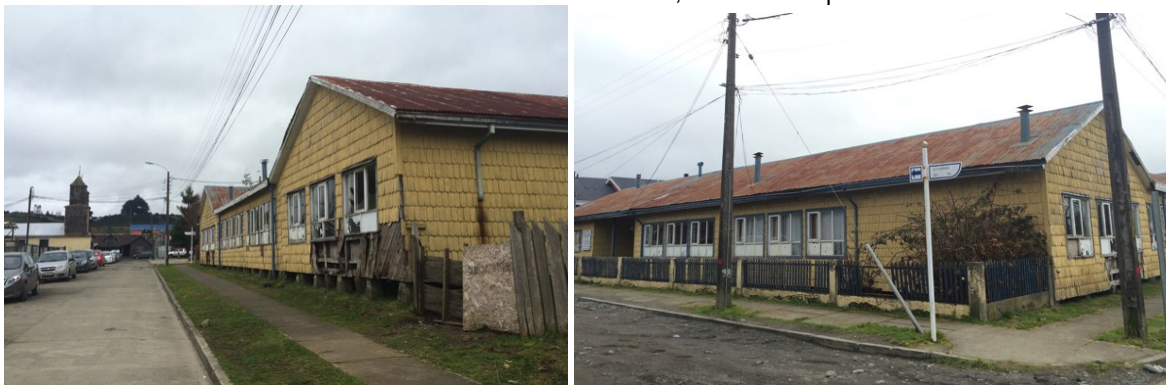
FIGURA N° 10-41 Fachada Poniente, Plaza de Puqueldón
