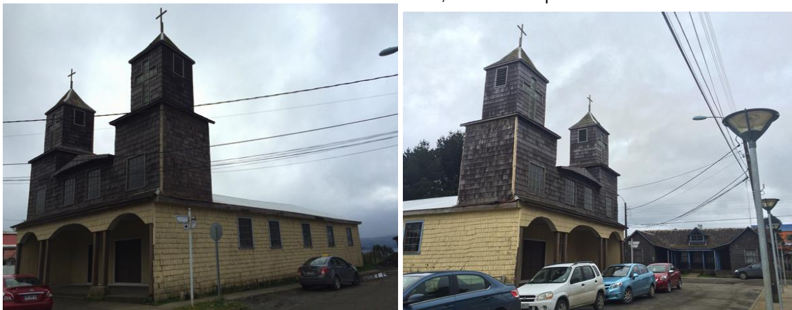
FIGURA N° 9-38 Fachada Norte, Plaza de Puqueldón
