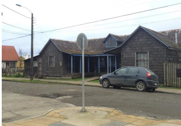
FIGURA N° 9-40 Fachada Oriente, Plaza de Puqueldón
