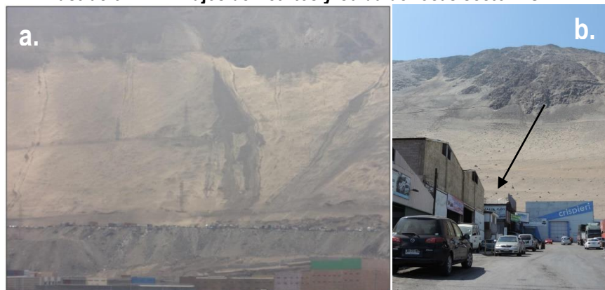
Ilustración 2-12 Flujos de Detritos y Caída de rocas sector ZOFRI
