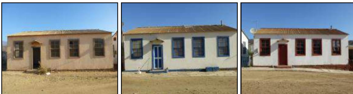
FIGURA N° 7-8: Viviendas Instalaciones Minera El Tofo
