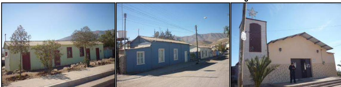
FIGURA N° 7-6: Consultorio General Rural La Higuera
