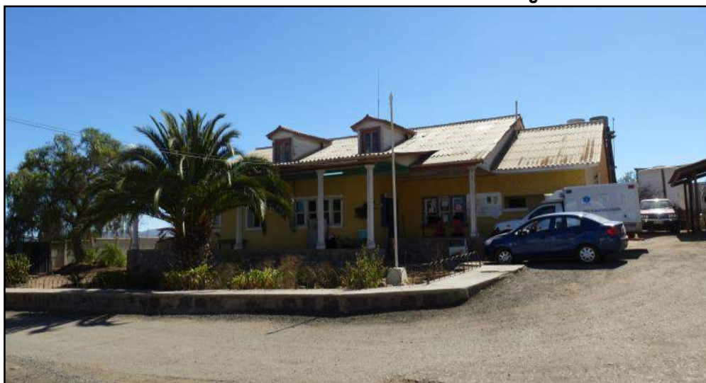
FIGURA N° 7-7: Consultorio General Rural La Higuera
