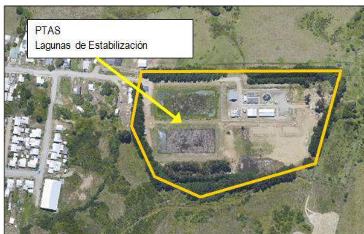
FIGURA N° 7-24: Limitante Planta de Tratamiento de Aguas Servidas ESSAL, Los Muermos
