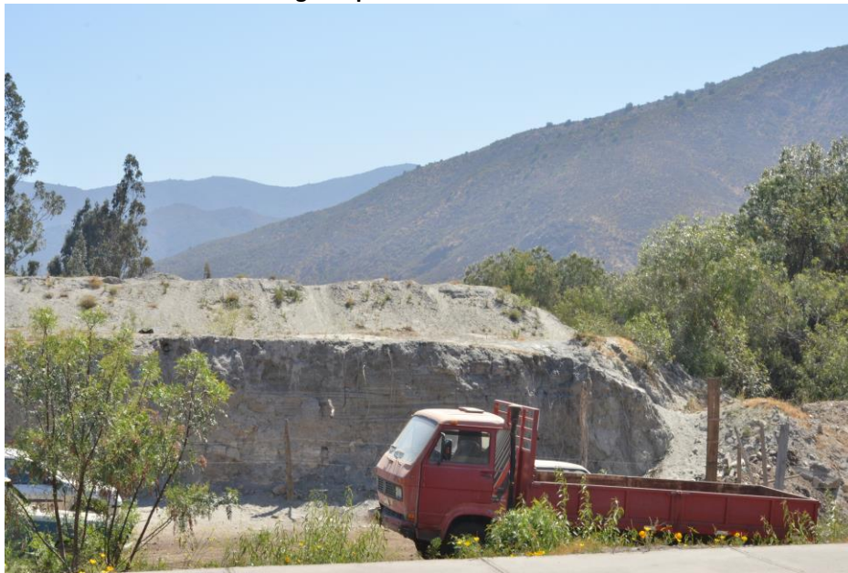
Fotografía 14: Vista de Relave abandonado de Mina San José junto al Puente que une Cabildo con Artificio sin ningún tipo de tratamiento
