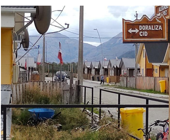
Figura 36. Tipología constructiva grupo 3 habitacional social.
