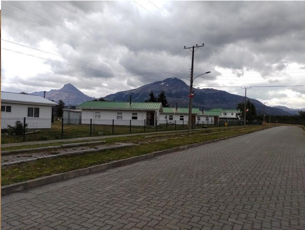
Figura 37. Tipología constructiva grupo 4 calle Río Mayer.
