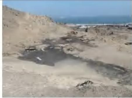
Detalle de los derrames de material del sitio hacia la faena de extracción de áridos cercana, producto del talud pronunciado de la torta de cenizas y escorias
