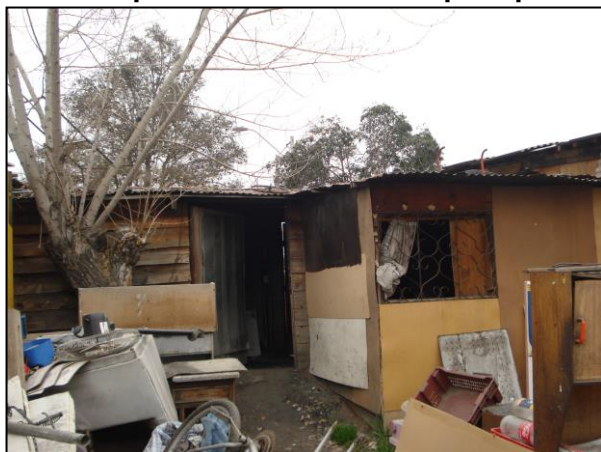
Fotografía 17: Interior Manzana - Instalaciones correspondientes a la vivienda principal
