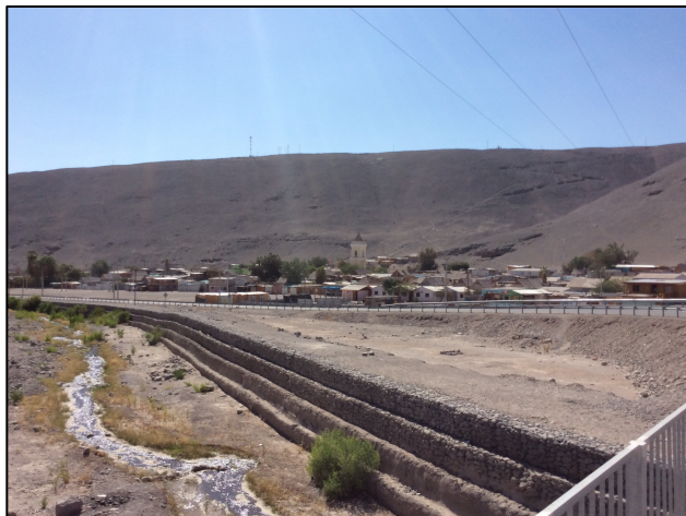
Fotografía 22: Vista de Gaviones que separan el lecho del río Tarapacá, poblado de Tarapacá
