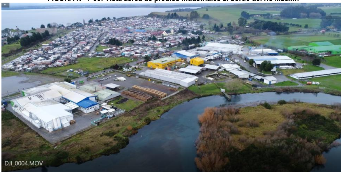
FIGURA N° 7-50: Vista aérea de predios industriales al borde del río Maullín
