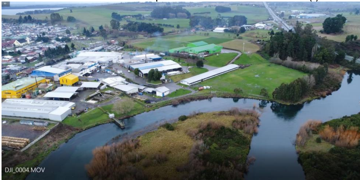
FIGURA N° 7-51: Vista aérea de predios industriales al borde del río Maullín (2)
