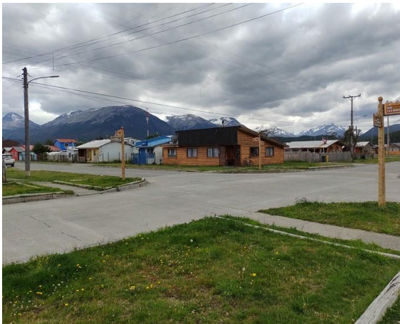
Figura 34. Tipología constructiva grupo 1 cruce Los Ñadis – Lago Christie.
