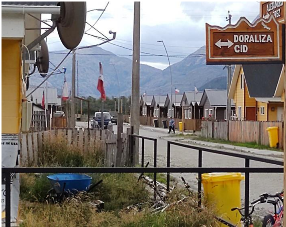
Figura 36. Tipología constructiva grupo 3 habitacional social.
