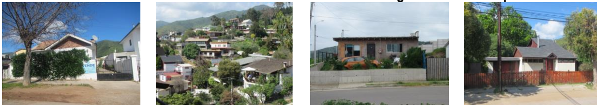
Ilustración 7.2-6 Caracterización de edificaciones Rango de Altura 1 a 2 pisos
