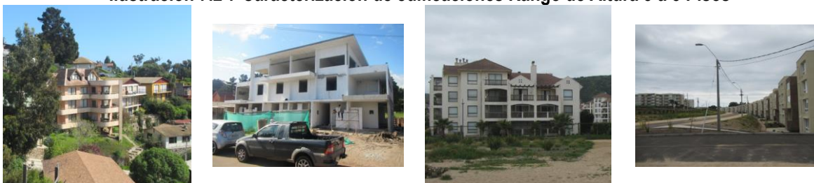
Ilustración 7.2-7 Caracterización de edificaciones Rango de Altura 3 a 5 Pisos
