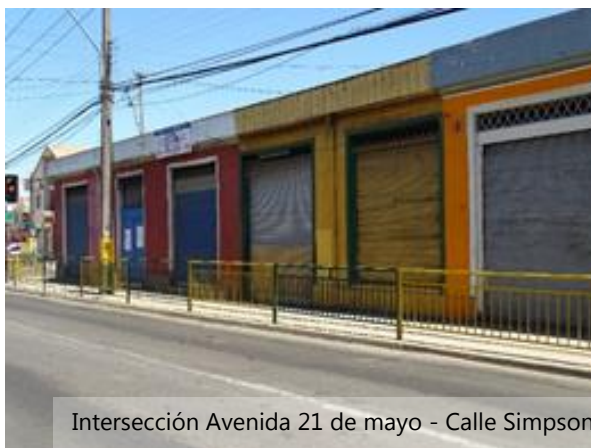
Intersección Avenida 21 de mayo - Calle Simpson
