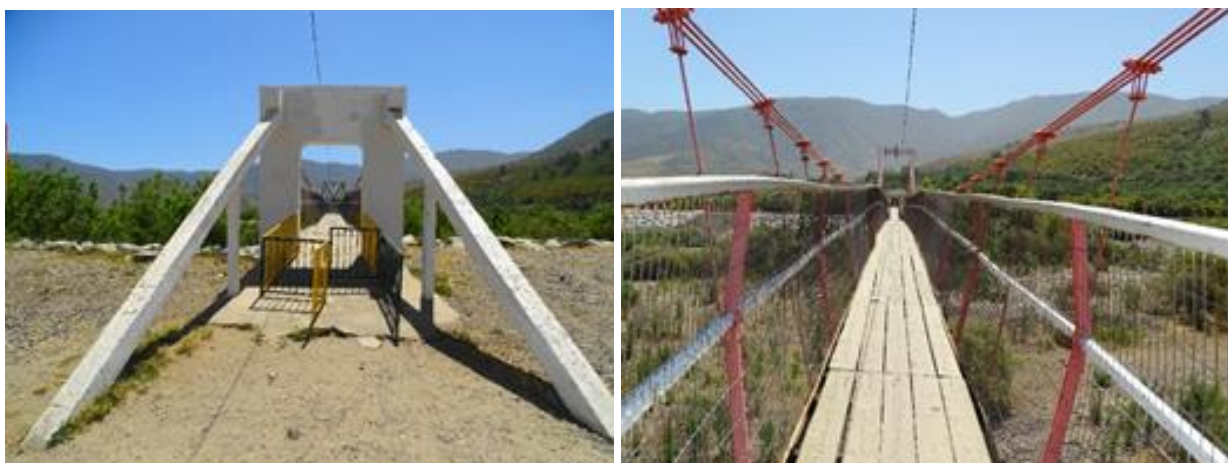
Figura 4-14 Imágenes Puente peatonal Lo Rojas
