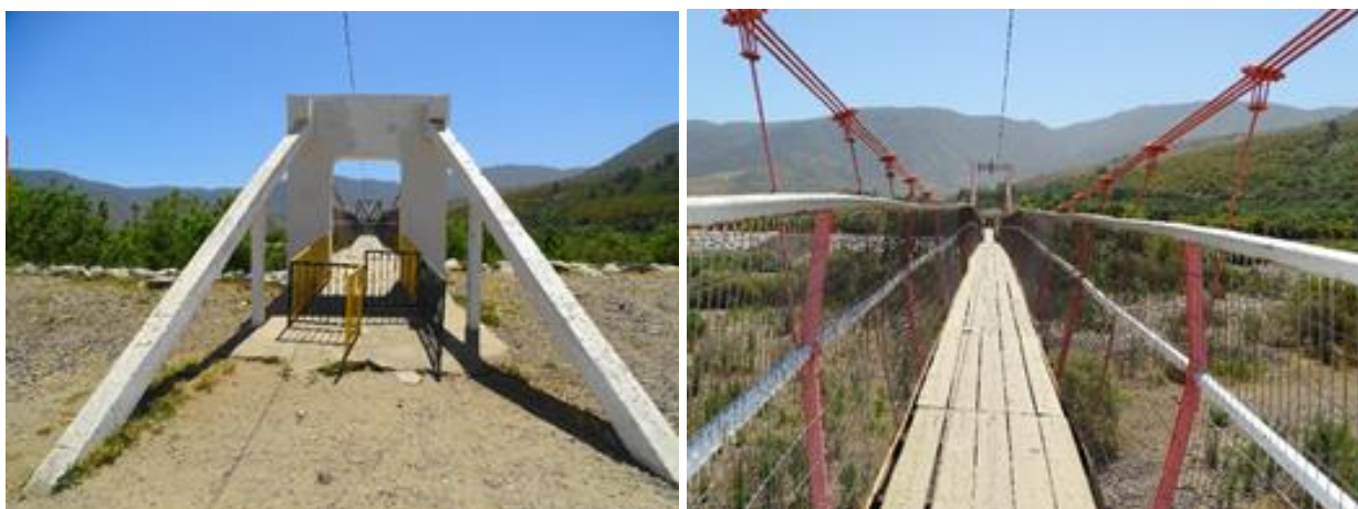
Figura 4-14 Imágenes Puente peatonal Lo Rojas
