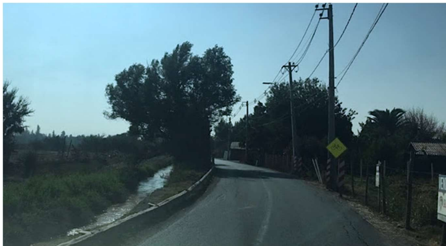
Fotografía 2: Canal El Carmen
