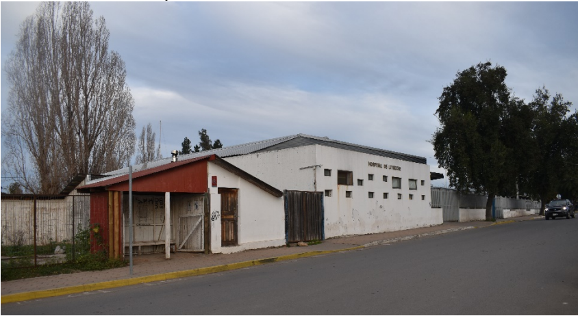
Ilustración 15 Hospital de Litueche
