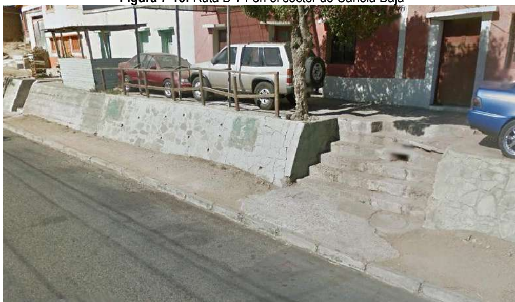
Figura 7-15: Ruta D-71 en el sector de Canela Baja
