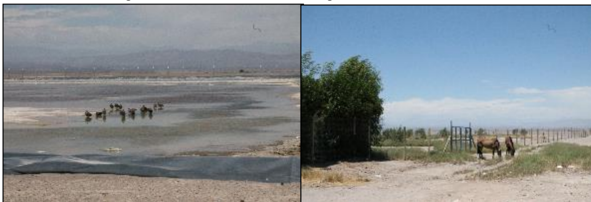
Fotografía 23: Planta de Tratamiento de Aguas Servidas, Localidad de Huara
