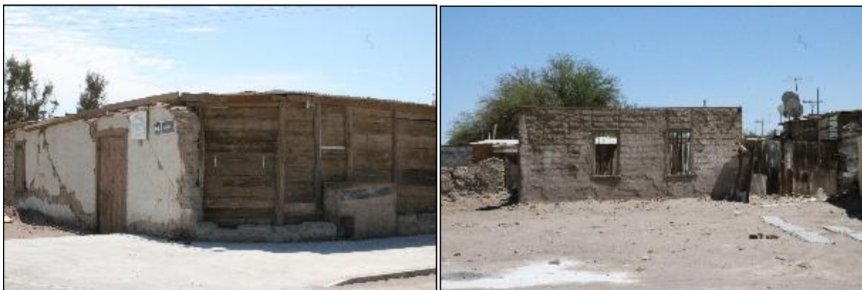
Fotografía 8: Estado viviendas de Huara tras terremotos del 2005 y 2014
