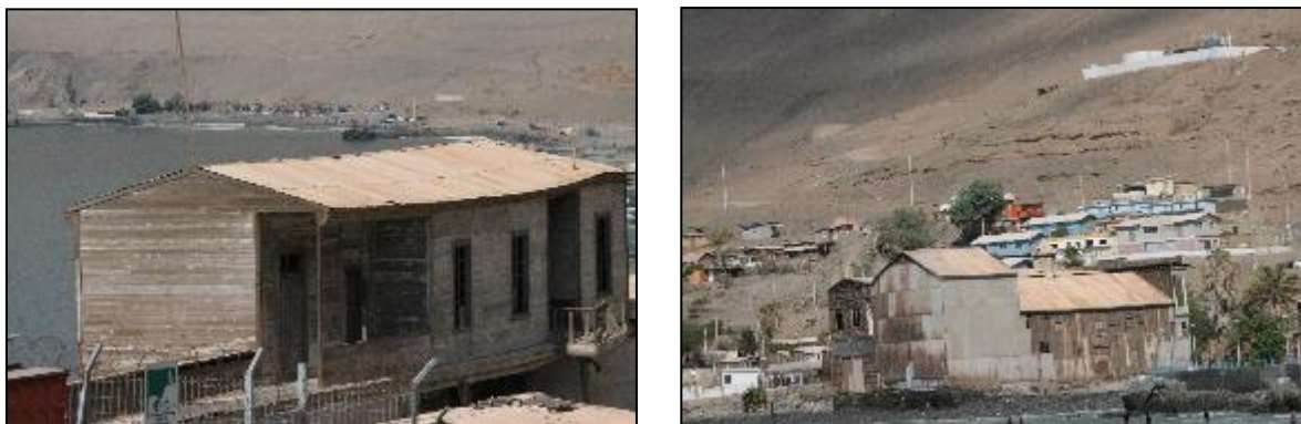
Fotografía 11: Estado de Conservación de Inmuebles de Valor Patrimonial
