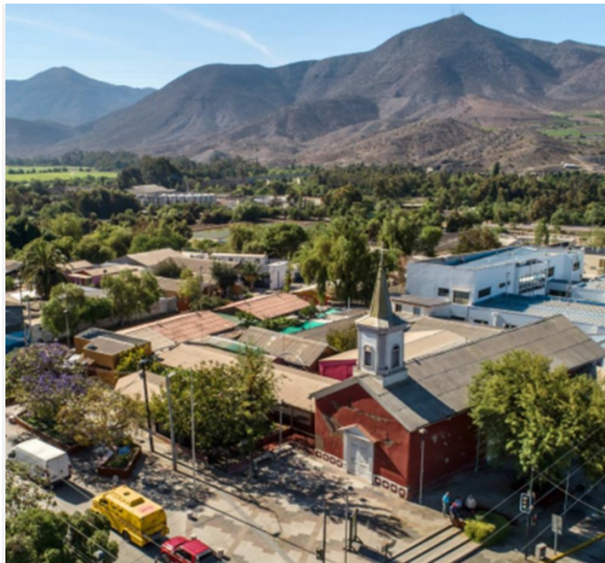
Fig. 36. Iglesia de Monte Patria. Patrimonio cultural en mal estado de conservación
