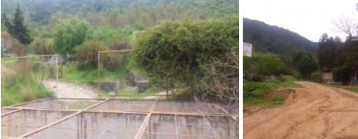
Foto. Infraestructuras decantadoras en Santa Luisa.
