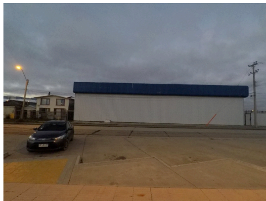
Fotografía 11: Galpón con motor en área urbana
