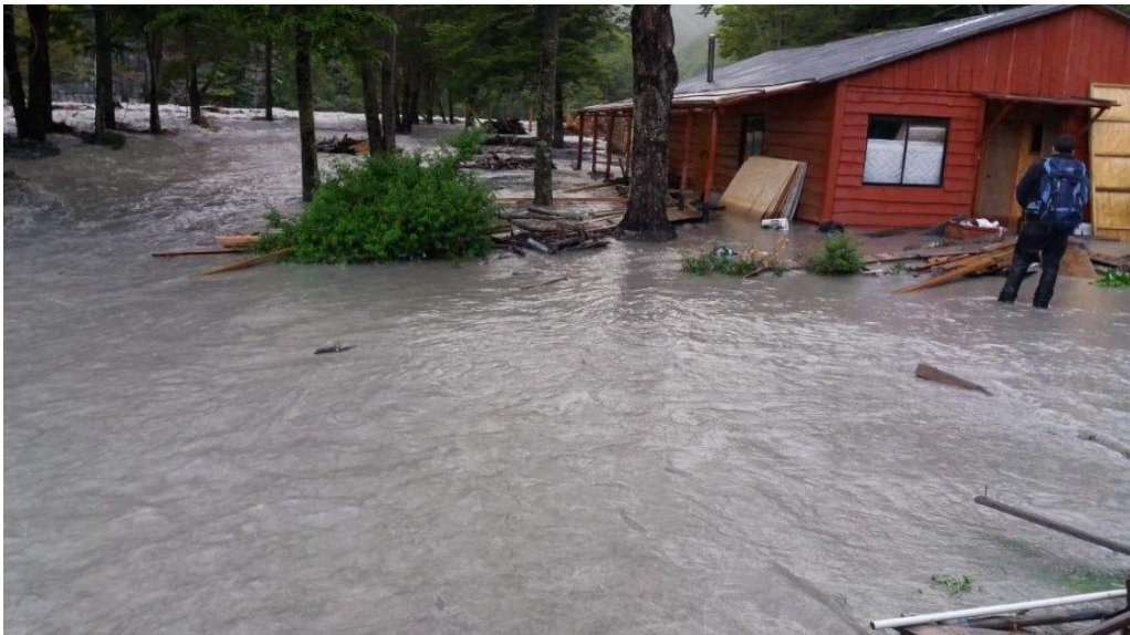
Figura 49. Inundación asentamiento humano de Villa O'Higgins.
