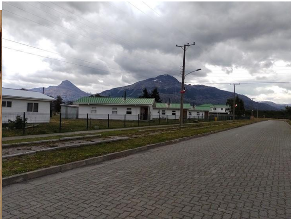
Figura 37. Tipología constructiva grupo 4 calle Río Mayer.
