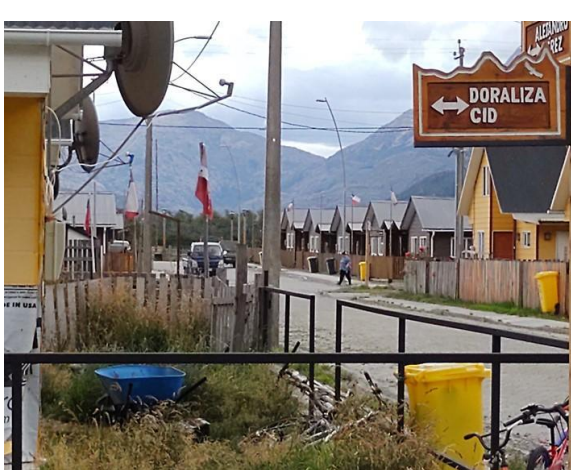
Figura 36. Tipología constructiva grupo 3 habitacional social.
