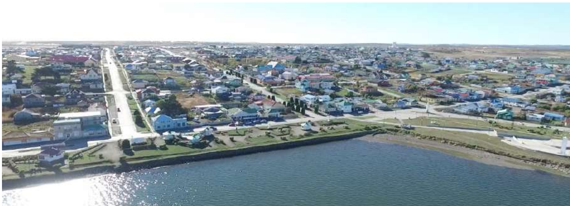
Figura 5: Fachada urbana del borde costero
