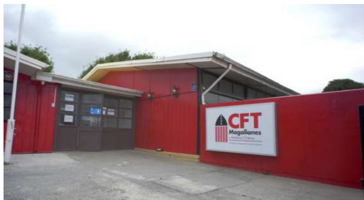
Figura 36. Centro de Formación Técnica (CFT Magallanes), localizado en la ciudad de Porvenir
