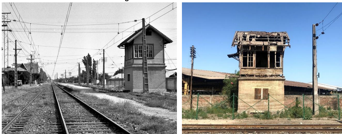
Figura 30. ICH: Caseta Ferroviaria
