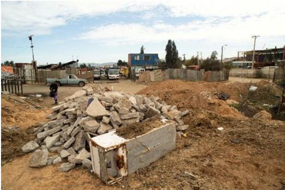
Fotografía 8: Vista de acopio de escombros en el área sur de Villa Alemana, en acceso a Cerro Frutilla
