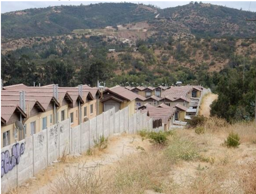
Fuente: Visita a terreno
