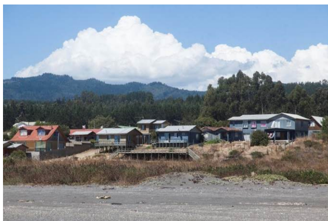
Fotografía 6. Viviendas construidas sobre dumas activas sector la Sirena, comuna de Pelluhue.
