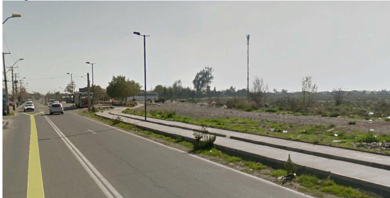
Fotografía 3: Ciclovía de calle Lo Martínez ubicada en borde oriente de la vía
