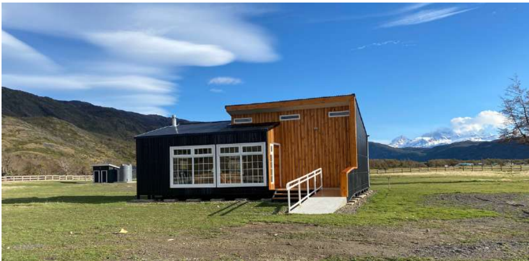
Figura 37. Equipamiento social en Villa Río Serrano, Salón Comunitario Villa Río Serrano
