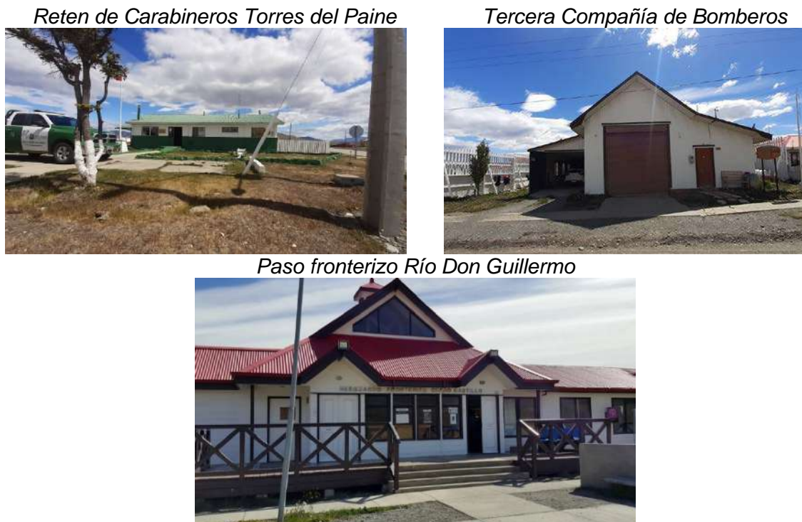
Figura 23. Equipamiento de seguridad en Villa Cerro Castillo
