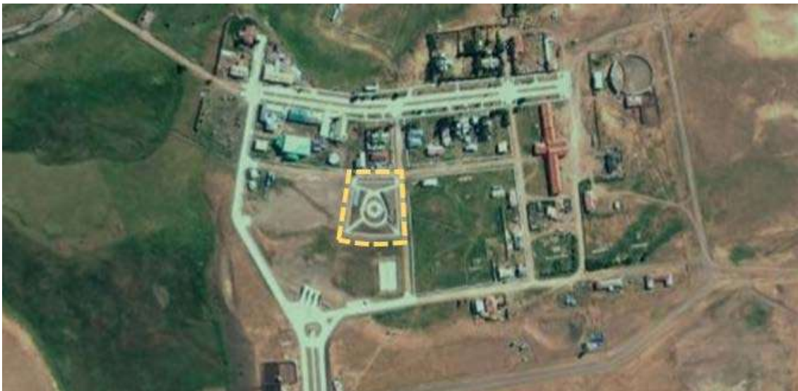
Figura 41. Construcción Plaza La Herradura Villa Cerro Castillo
