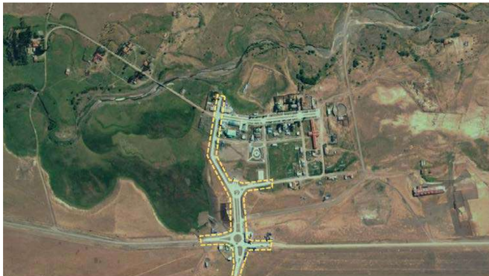
Figura 40. Construcción Calle Ovejero, Cerro Castillo
