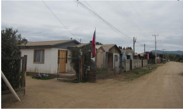
Situación de fachadas (3 oriente)
