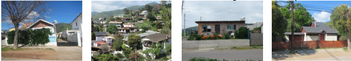
Ilustración 7.1-9 Caracterización de edificaciones Rango de Altura 1 a 2 pisos
