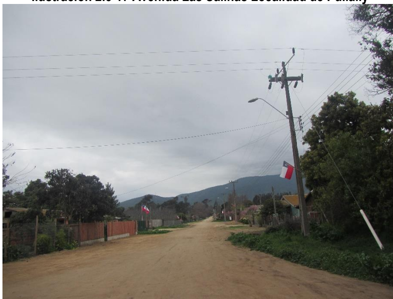
Ilustración 2.5-17 Avenida Las Salinas Localidad de Pullally
