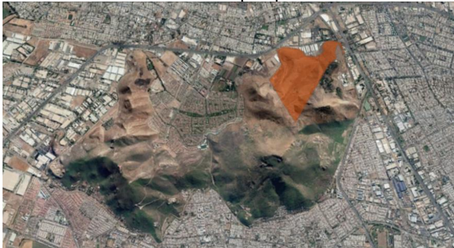
FIGURA N° 9-6: Vista General del Terreno ocupado por el Ex Vertedero Cerros de Renca
