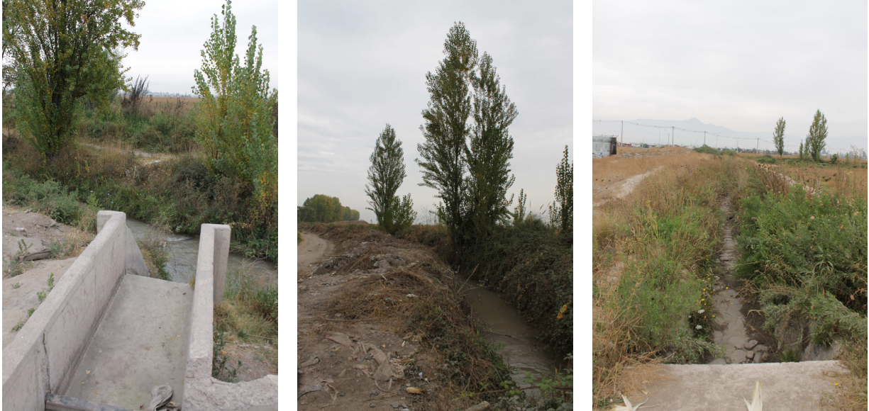
Fotografía 6: Canales del Fundo La Platina
