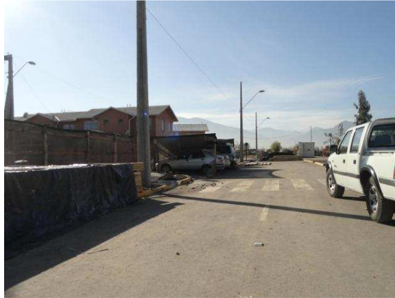
Fotografía 1: Construcción conjunto habitacional, Sector Barrio Santo Tomas
