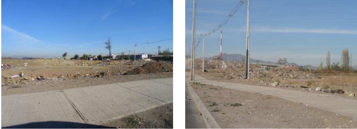
Fotografía 14: Robo de cercos, Borde interno norte del Fundo La Platina
