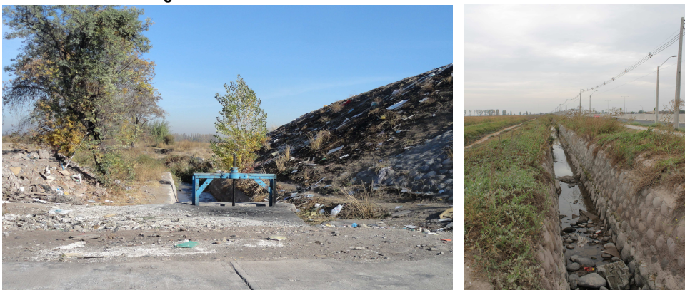
Fotografía 16: Situación canales en el interior del Fundo La Platina
