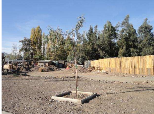
Fotografía 2: Construcción conjunto habitacional, Sector Barrio Santo Tomas
