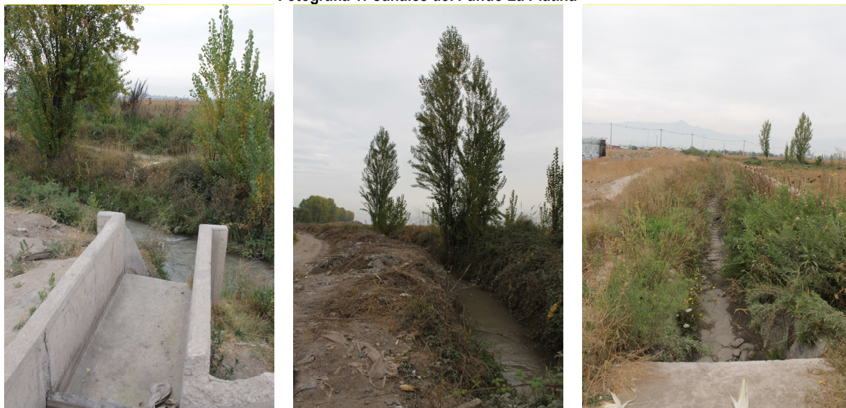
Fotografía 1: Canales del Fundo La Platina
