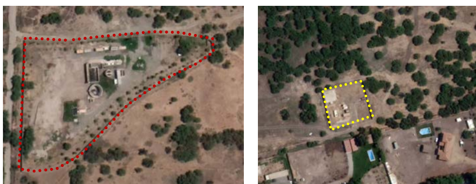
Figura 22: Planta de Tratamiento de Aguas Servidas y Planta de Tratamiento de Agua Potable
