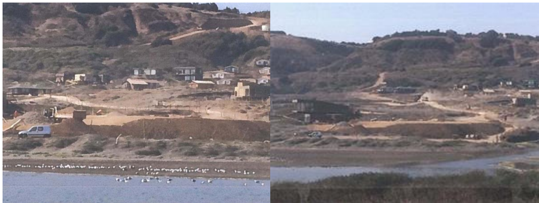
Fotos aportadas por vecinas de las Vegas de Pupuya denunciando grandes movimientos de tierra en sector norte del estero, modificando área de la laguna y arenal natural (Ver anexo)
