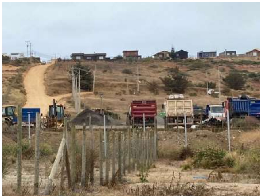
Urbanización y contaminación acústica asociada
