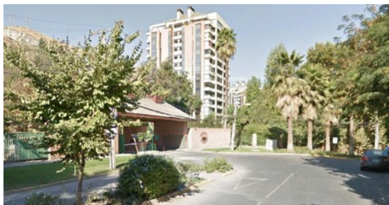
Fotografía 10: Edificación en altura, sector La Pirámide
