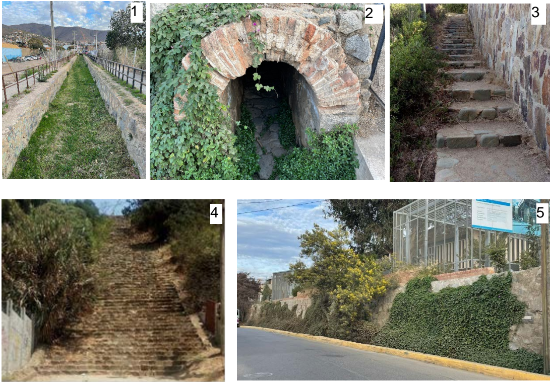
Figura 50. Elementos urbanos relevantes en La Ligua
