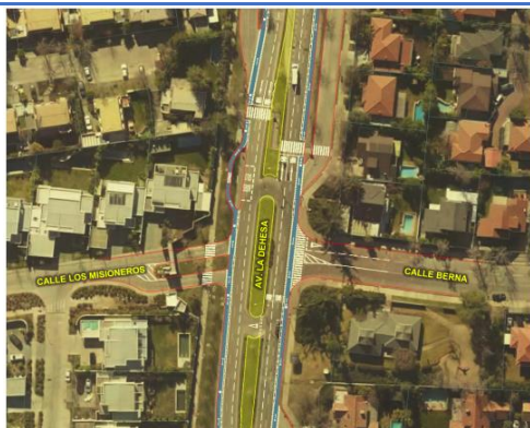
Intersección Av. La Dehesa con calle Berna
