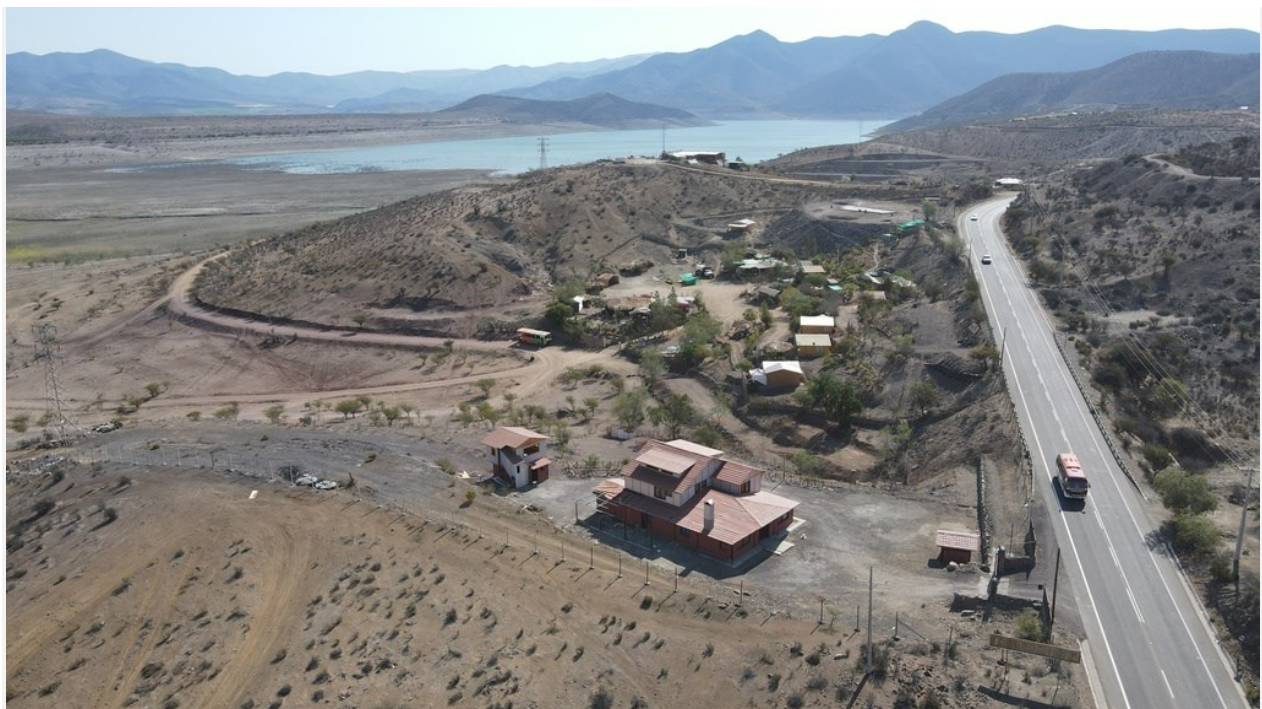
Fig. 26. Presión de urbanización sobre ambientes naturales (sector Las Paceras junto a Embalse La Paloma) Fuente: Archivo fotográfico del Consultor, 2022
