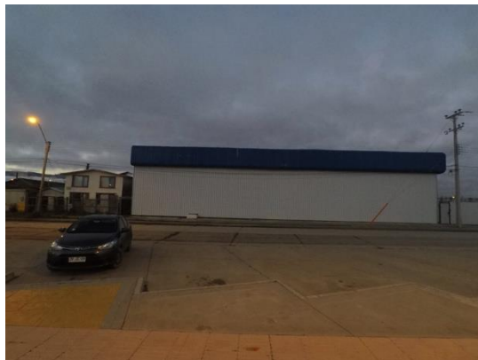
Fotografía 11: Galpón con motor en área urbana
