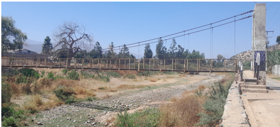
Fig. 21. Situación del estero El Melón en sector Pasarela Peatonal
