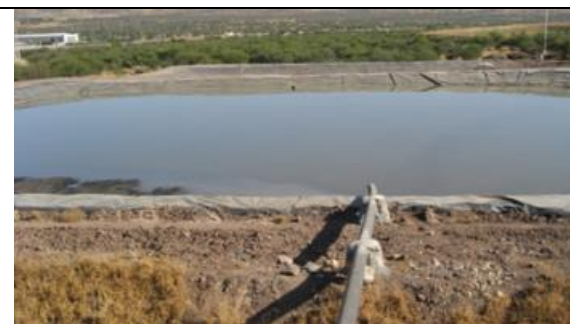
Foto 8. Laguna anaeróbica planta Porkland Chile.
