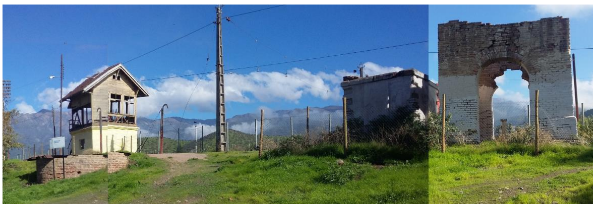
Foto 3. Subestación Eléctrica de Ferrocarriles
