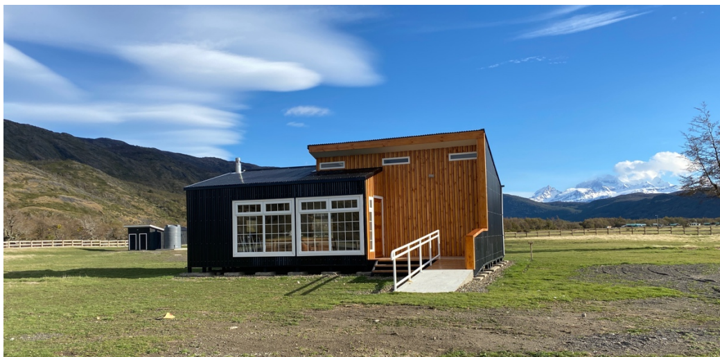
Figura 34. Equipamiento social en Villa Río Serrano, Salón Comunitario Villa Río Serrano
