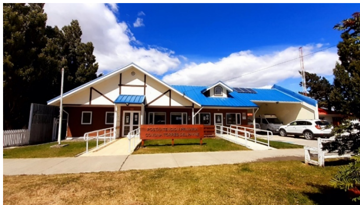
Figura 19. Equipamientos de salud en Villa Cerro Castillo
